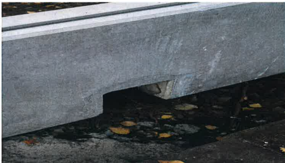
Abbildung 7 Durchlass in einem SSW-Sockelelement.
