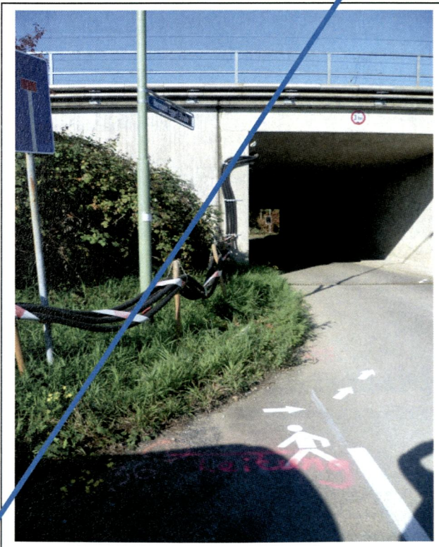
Bild 2. EÜ Ladestraße; S/B/DPH 136
