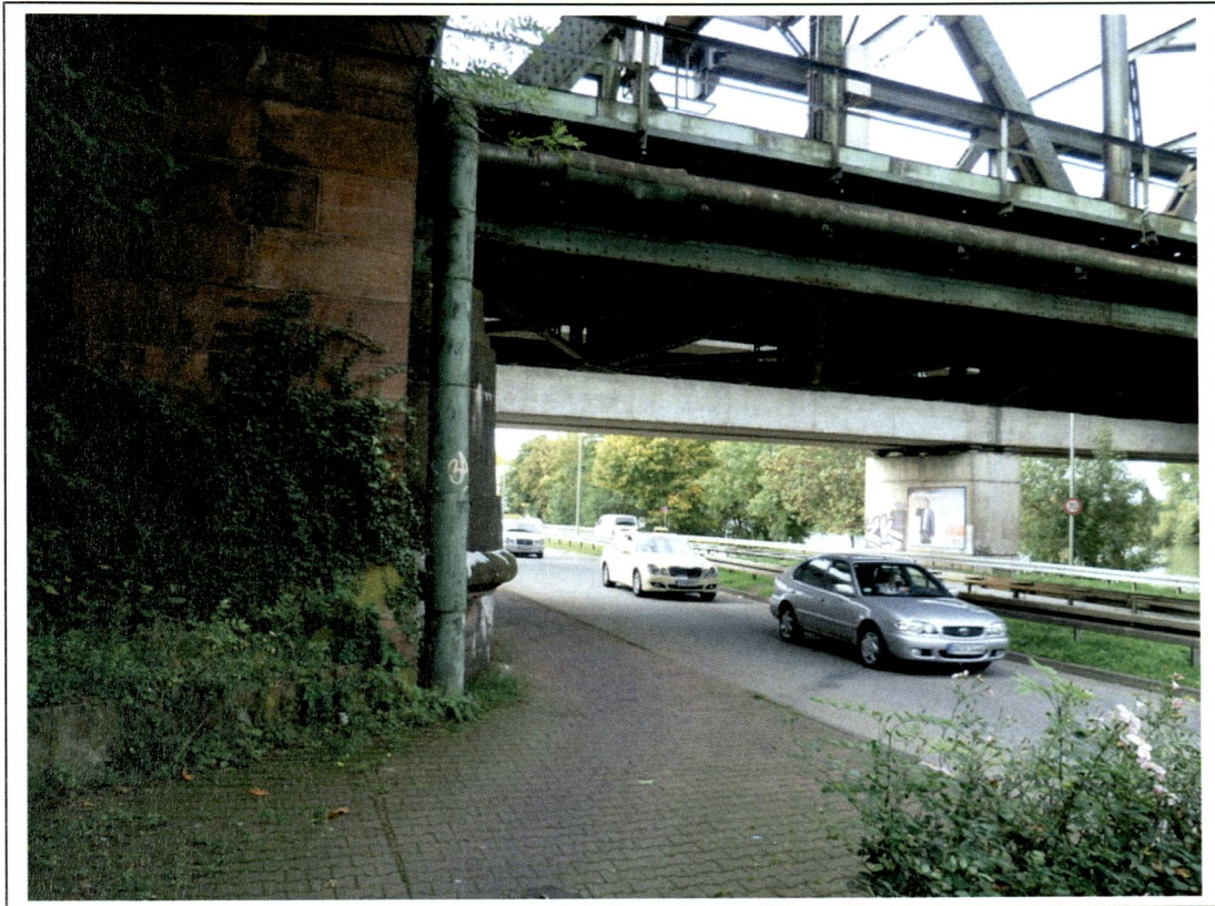
Bild 3. EÜ Mainbrücke, Widerlager Süd an Niederräder Ufer
