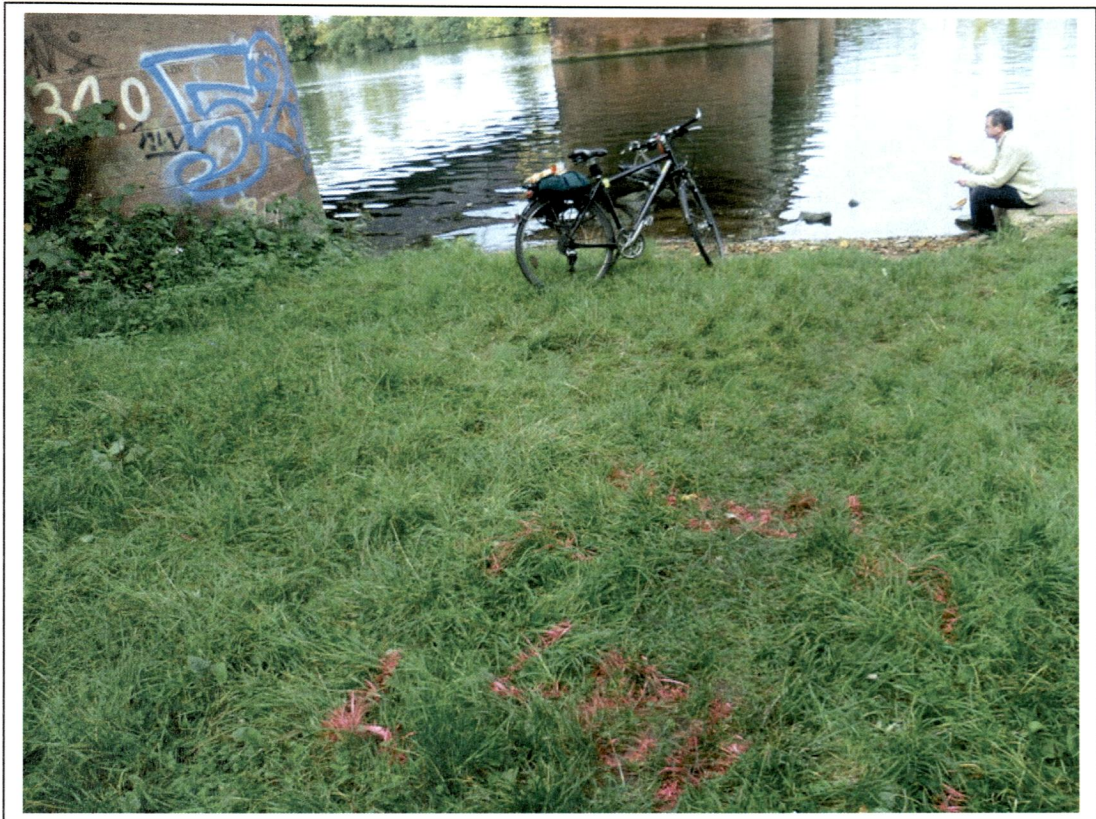
Bild 5. EÜ Mainbrücke, S/B/DPH 121, südliches Mainufer
