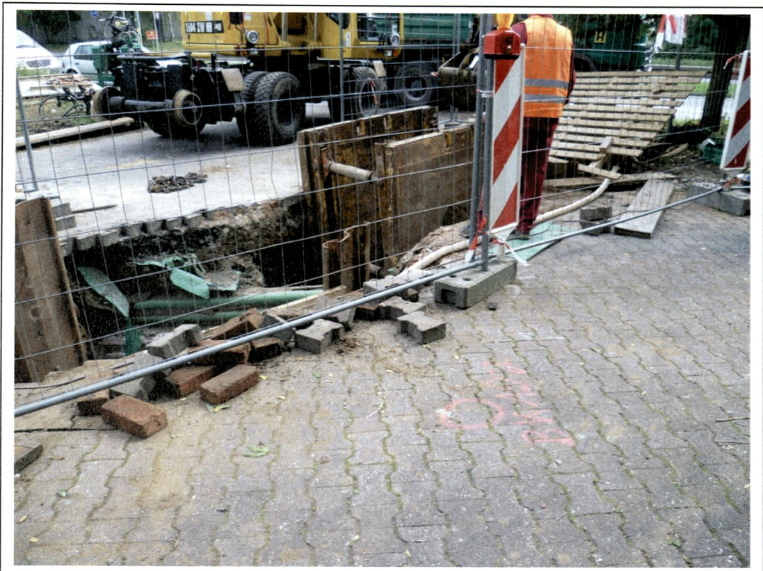
Bild 1. EÜ Gutleutstraße - Einfahrt Fa-Stellwerk; S/B/DPH 127
