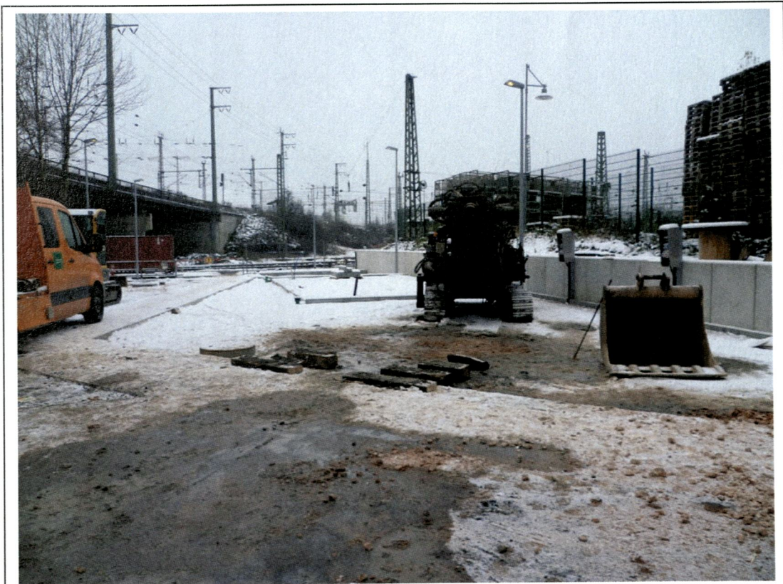
Bild 9. EÜ Gutleuthof; S/B/DPH 132A; neben Fa-Stellwerk versetzt
