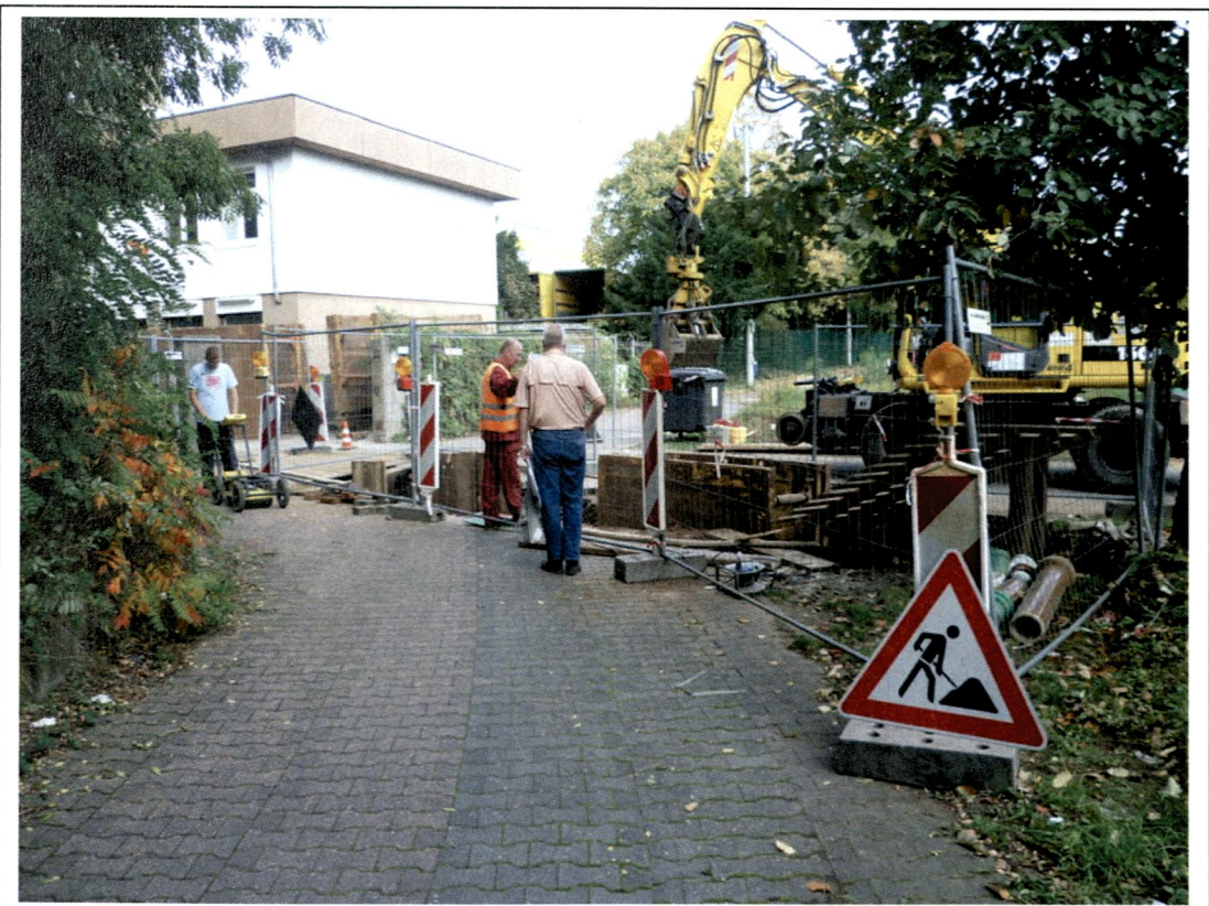
Bild 2. EÜ Gutleutstraße - Einfahrt Fa-Stellwerk; S/B/DPH 127
