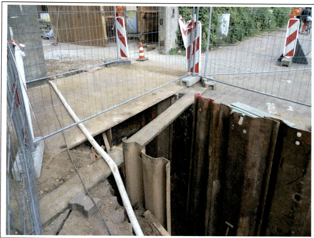
Bild 3. EÜ Gutleutstraße; S/B/DPH 127; Kabelarbeiten in Einfahrt zum Fa-Stellwerk
