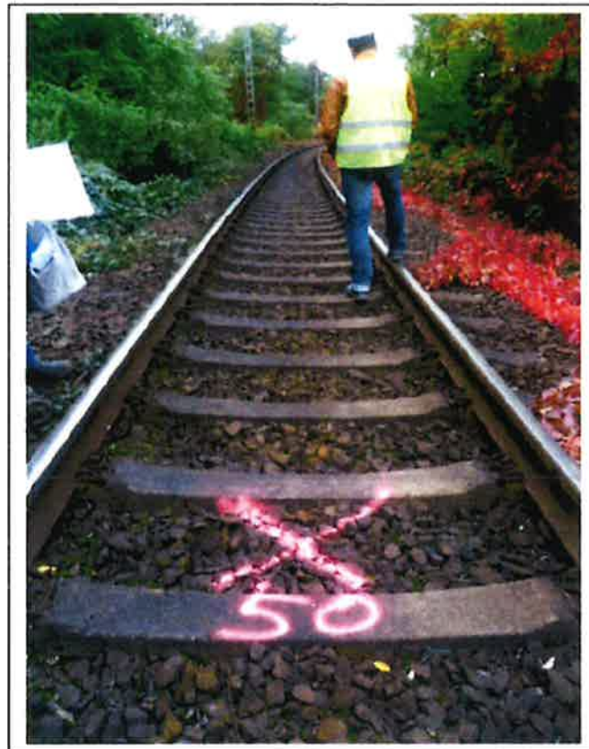
Bild 5 Ansatzpunkt S/RKS 50 (Bereich km 6,1 - 7,15, Strecke 3624)
