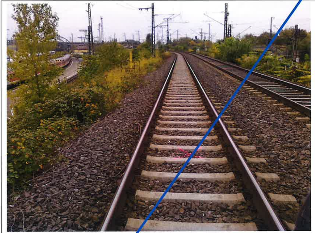
Bild 11. S/RKS 143, Damm Richtung Ffm Niederrad
