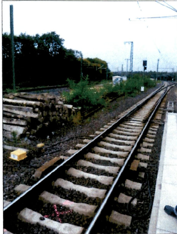
Bild 1. Ansatzpunkt S/RKS 1, Blickrichtung in absteigende Kilometrierung
