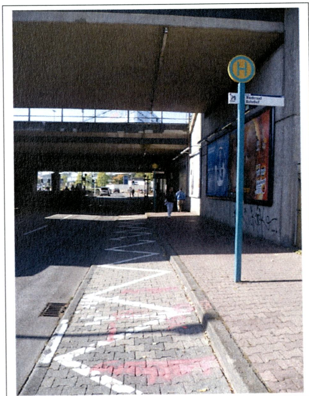
Bild 2. EÜ Adolf-Miersch-Straße, Bahnhof Frankfurt(M)-Niederrad; S/B/DPH 97
