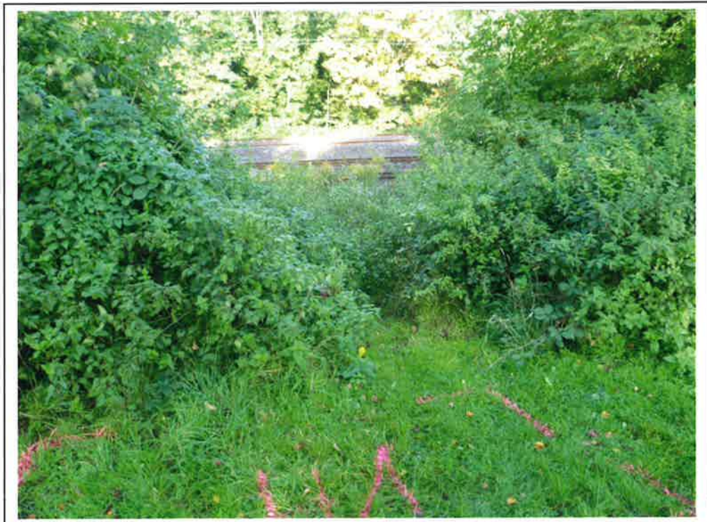
Bild 4. S/RKS/DPH 41, Damm bahnrechts oberhalb Str. 3520 km 32,129
