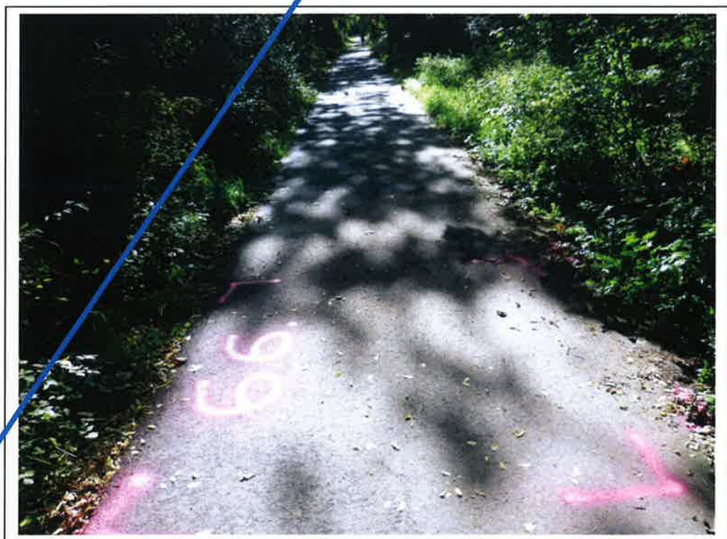
Bild 2. Bereich EÜ Golfstraße Weg bahnrechts; Blickrichtung absteigende Kilometrierung; S/RKS 66
