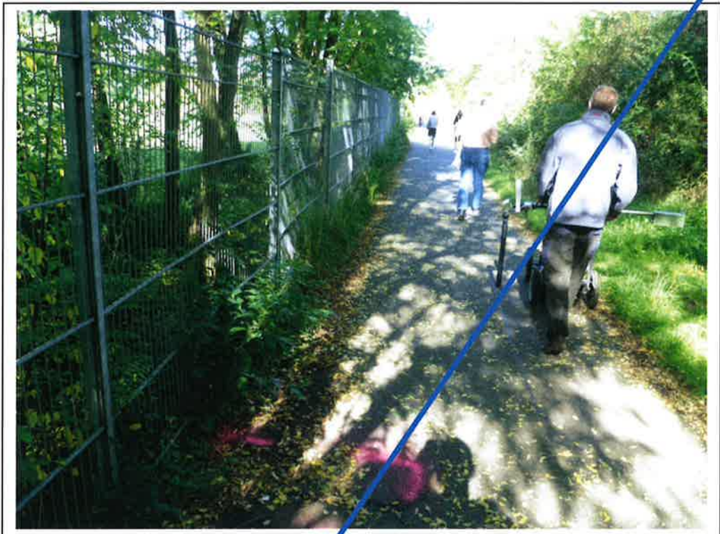
Bild 5. Bahnrechter Dammfuß Blickrichtung absteigende Kilometrierung; S/RKS 80
